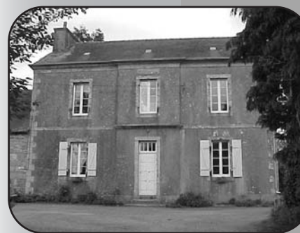
La transformation de l'ancien presbytère en une salle polyvalente de taille adéquate pour la commune.
