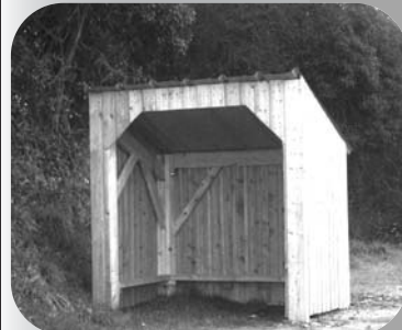
Abri-bus de Saint-Lubin
