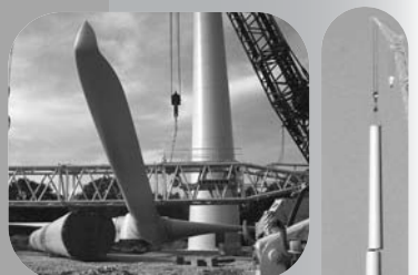
La grue LG 1750 «lubin» assure le montage des parties «hautes».
