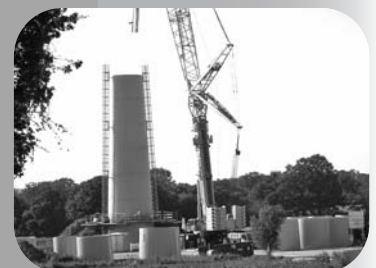
Les grues AC 500 «Lisa» et AC 700 «Marceau», de Dufour, qui assurent les montages des anneaux béton.
