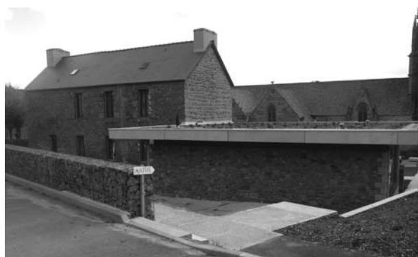
Vue arrière de la mairie rénovée
