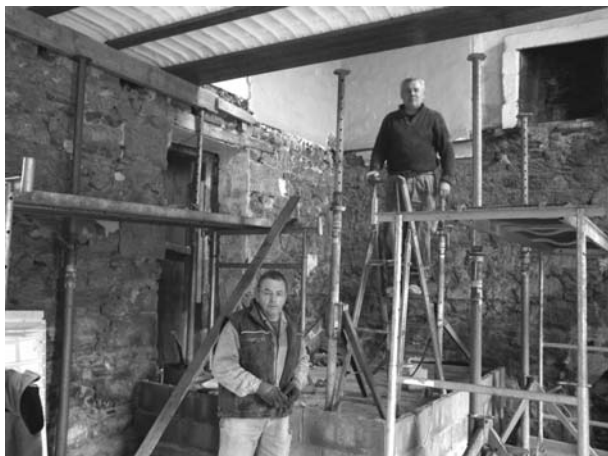
Travaux de maçonnerie dans la future salle de réunion
