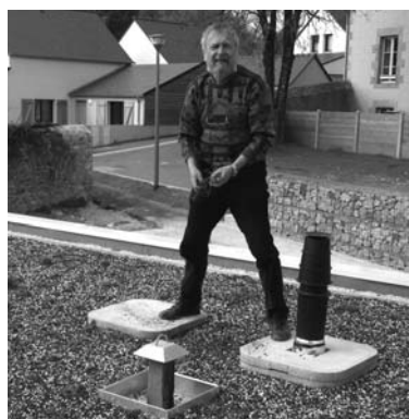
M. Gosselin vérifiant le toit végétalisé de la nouvelle mairie
