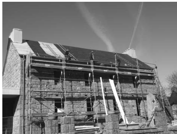
Réfection de la toiture
