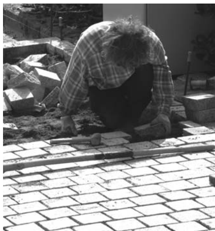
Pose de pavés le long de la façade
