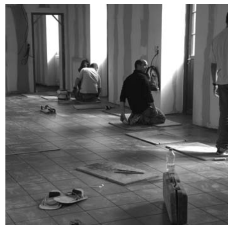
Finition des joints de carrelage
