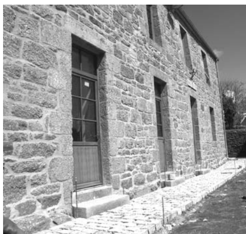
Pose de pavés le long de la façade
