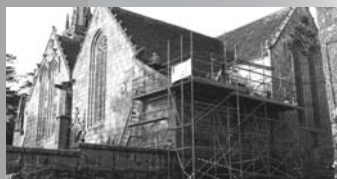
Travaux en cours
